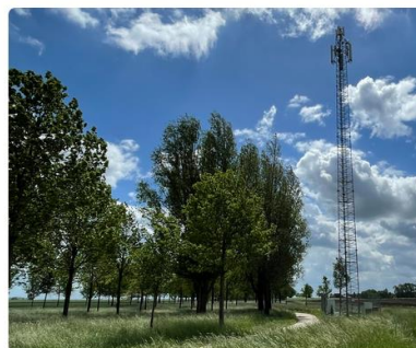
De nieuwe mast
