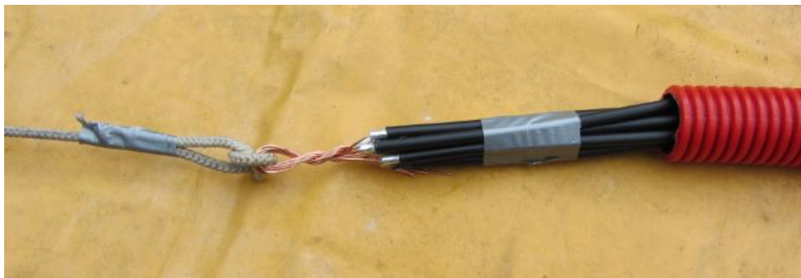
Figuur 2: door een 30 meter lange buis acht coaxkabels trekken
