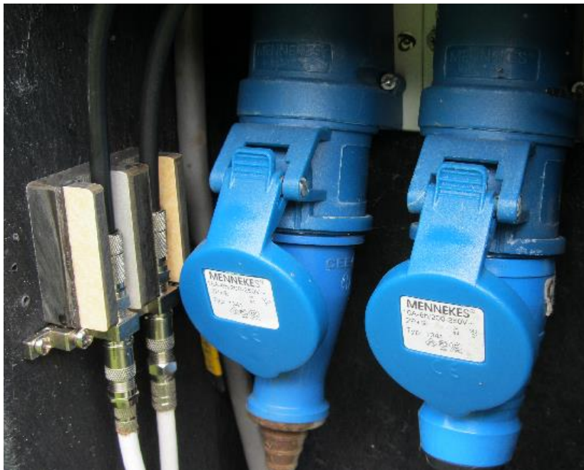
Figuur 9: zwart is het vaste deel, wit is de caravan coax met snelkoppeling
